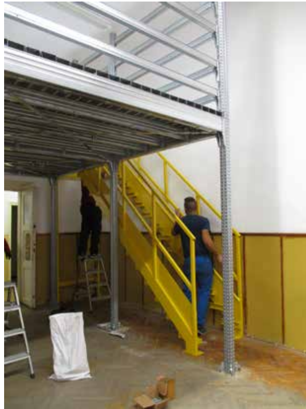
11. A galériás tárolórendszer építése
